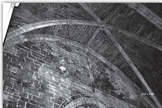
Detalle de la parte alta del presbiterio en su estado actual con Calvario original. Foto J. L. Vila
